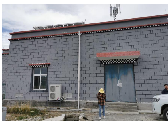
观测基地泵房
