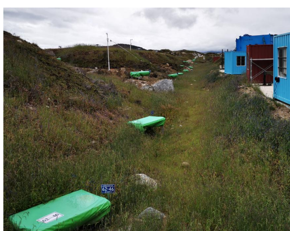
东小溪联通渠管涵
