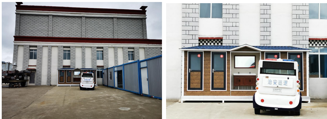
装配大厅外移动卫生厕所
