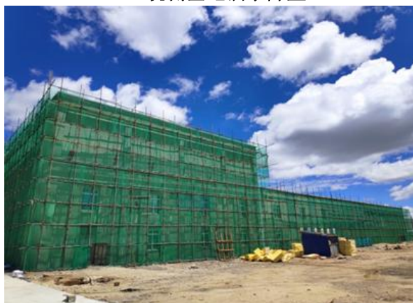
测控基地施工围挡
