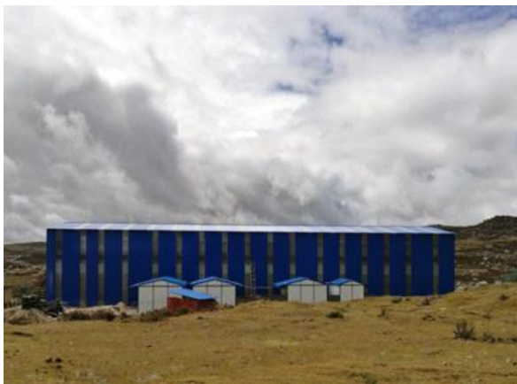
MD 现场钢结构加工车间
